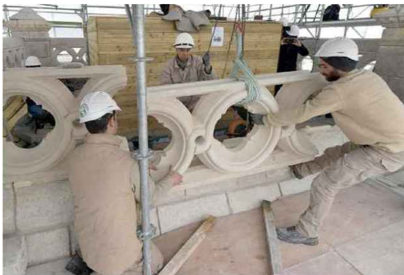
Des tailleurs de pierre installent un nouveau balustre tout en haut de l'une des tours.
