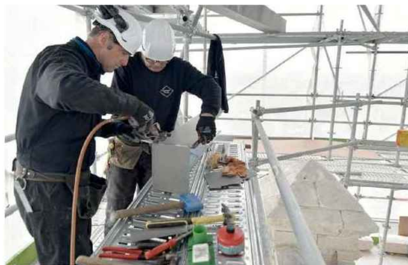
Des travaux sur une gouttière.
